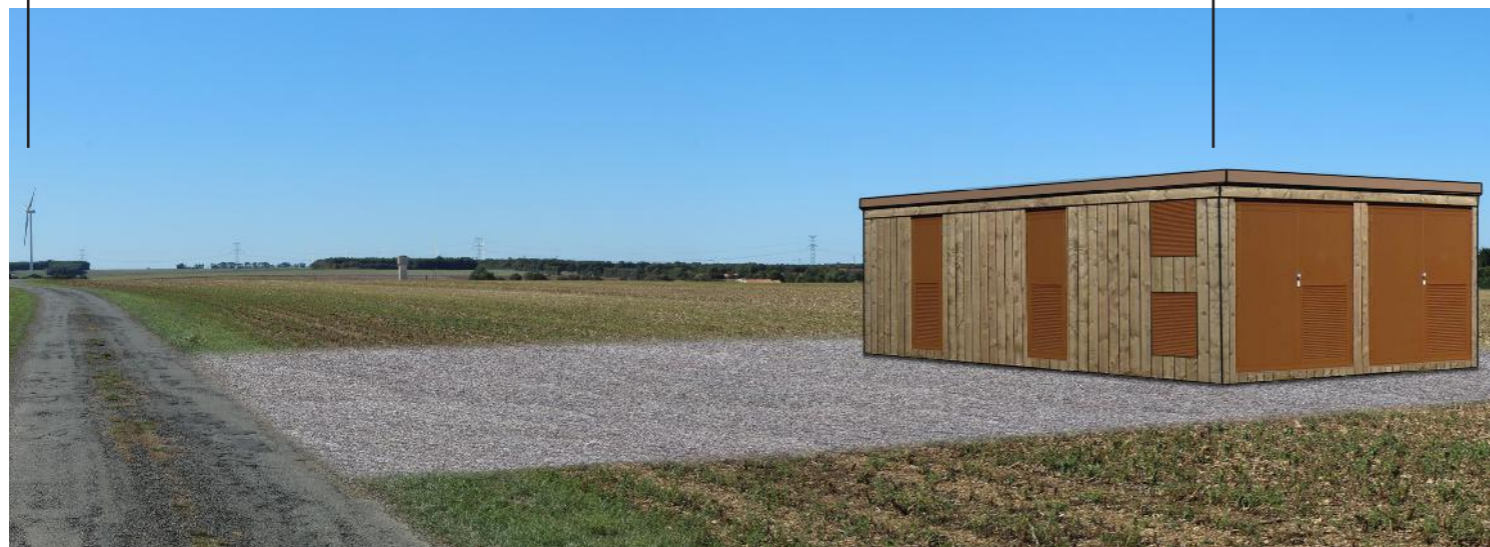
Fig. 389 : Intégration du poste de livraison proche de l'éolienne E2
