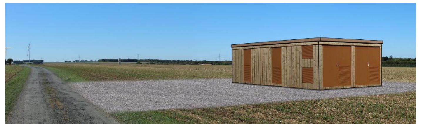
Fig. 396 : Intégration du poste de livraison
