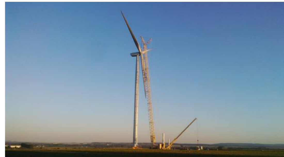
Fig. 387 : Assemblage d'une éolienne
