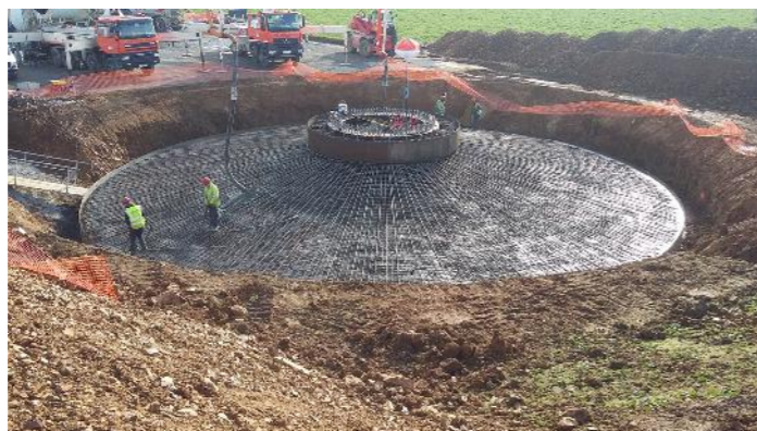
Fig. 384 : Mise en place d'une fondation
